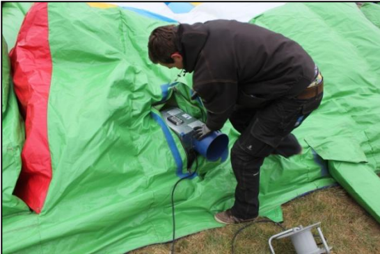
Stap 7: Plaats in het maangat een blower.
