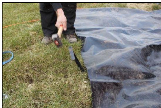
Stap 24: Sla de haring schuin van het kussen.
