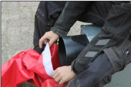
Stap 7: Sluit de luchtslang aan de blower.
