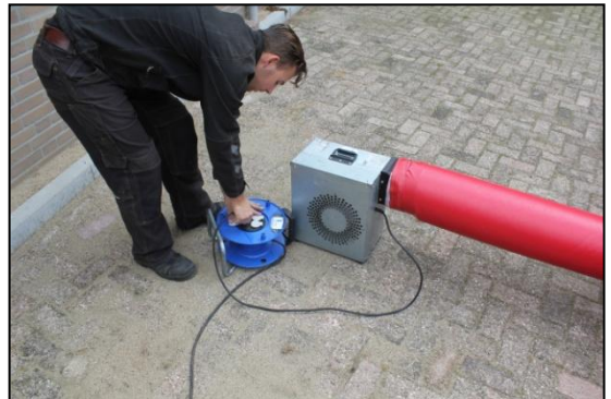
Stap 8: Stop de stekker in de geaarde en volledig afgerolde haspel.
